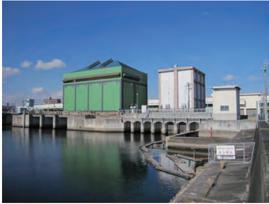
写真7 中川口ポンプ場
