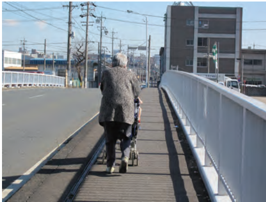
写真9 八熊橋の狭い歩道を渡る高齢者
